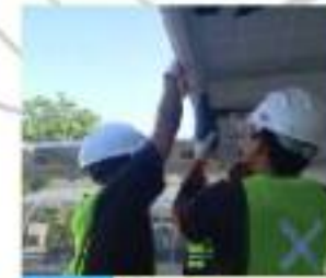
Pembangunan PLTS 10 kWp
